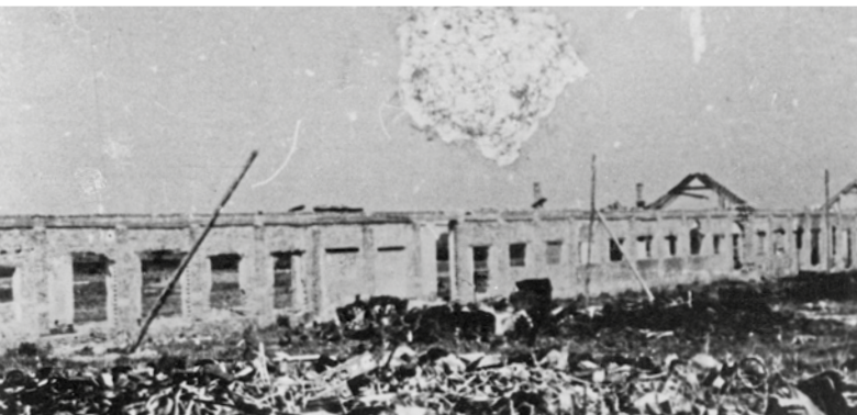
ОСТАЦИ ЛОГОРА ЈАСЕНОВЦА III – ЦИГЛАНА НАКОН РУШЕЊА У АПРИЛУ 1945. ГОДИНЕ [МЖГ, ЗАВГ] REMAINS OF JASENOVAC III – BRICKYARD CAMP AFTER DESTRUCTION IN APRIL 1945 [MŽG, ZAVG]
